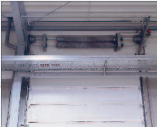
T30 Sectionaltor mit höhergeführtem Laufschienebeschlag.
